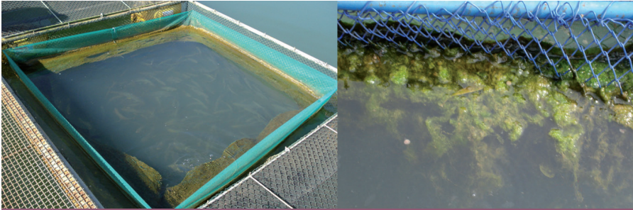
Figuras 45 e 46 - Colmatção das telas
