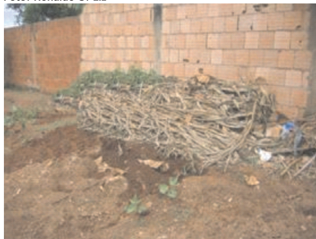
Fig. 1. Muro próximo à horta.
